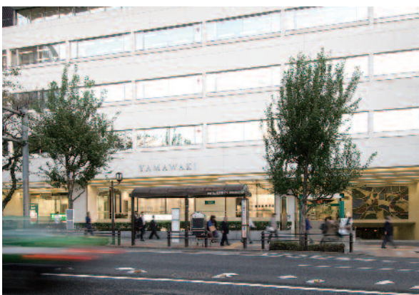
山脇美術専門学校 （山脇ビル正面・地上12階、地下2階）
